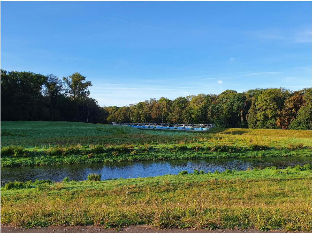
Blick auf das Nahleauslassbauwerk von der Neuen Luppe aus, Foto: Kathleen Burkhardt-Medicke
